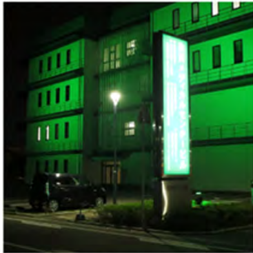
佐賀メディカルセンタービル 提供元：公益財団法人 佐賀県臓器バンク
